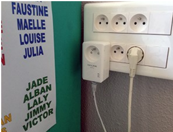
Jean Rostand : Mise en place de prise de courant porteur en ligne pour permettre l'accès internet dans toutes les classes.
